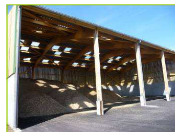
4 à 6 mois de stockage sous abri
